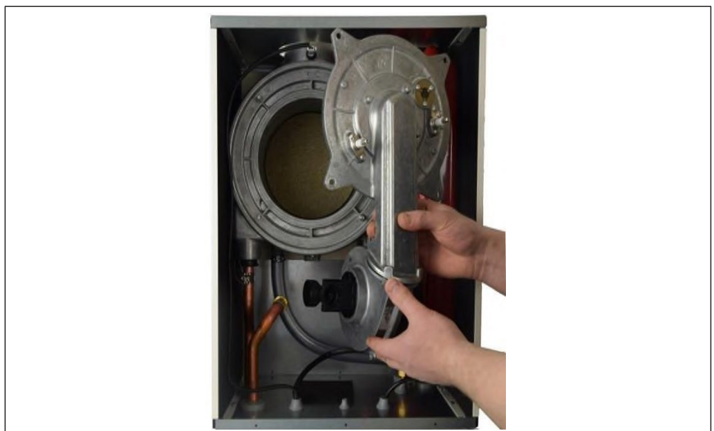
Рис. 22: Снятие смесителя горелки
