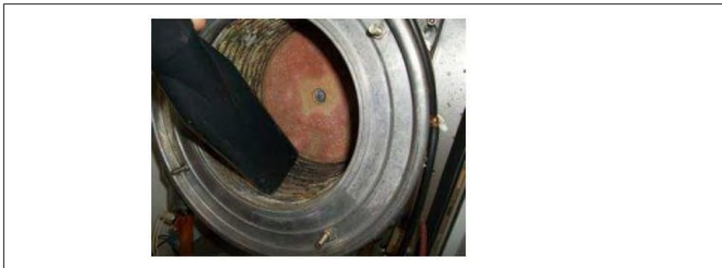
Рис. 23: Чистка камеры сгорания
